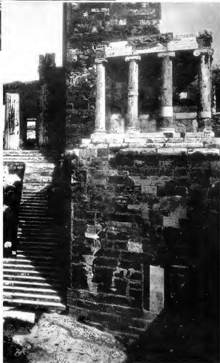
Figura 7.40. Ingrandimento della vecchia fotografia risalente al 1860. È chiaramente visibile che la torre ottomana medievale e le fondamenta "antiche" del tempio di Atena Nike hanno una muratura identica e sono costruite con lo stesso tipo di pietra. Ovviamente, queste costruzioni appartengono alla stessa epoca. Tratto da [198], pagina 39.
